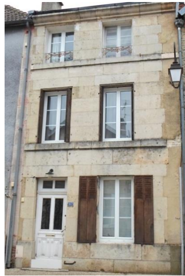
Façade en pierre de taille calcaire.
