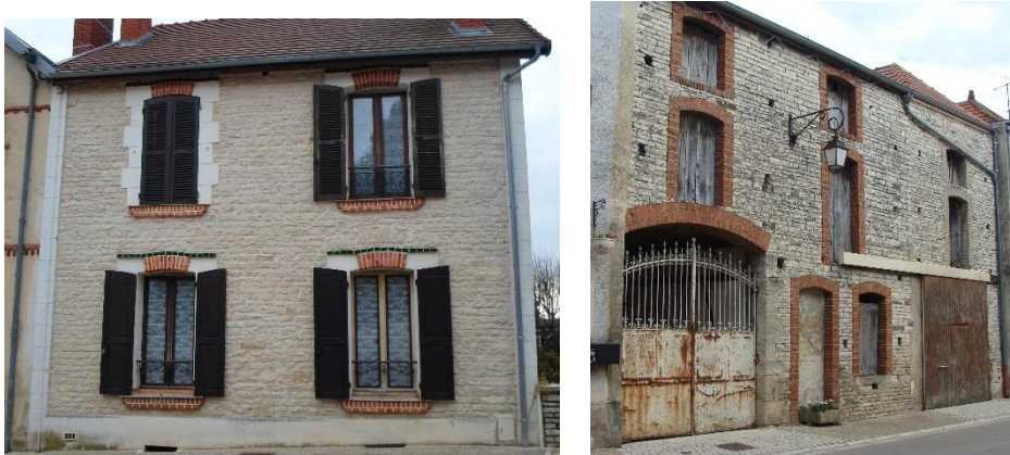
Façades avec encadrements de baies en brique et remplissage en moellon de pierre
