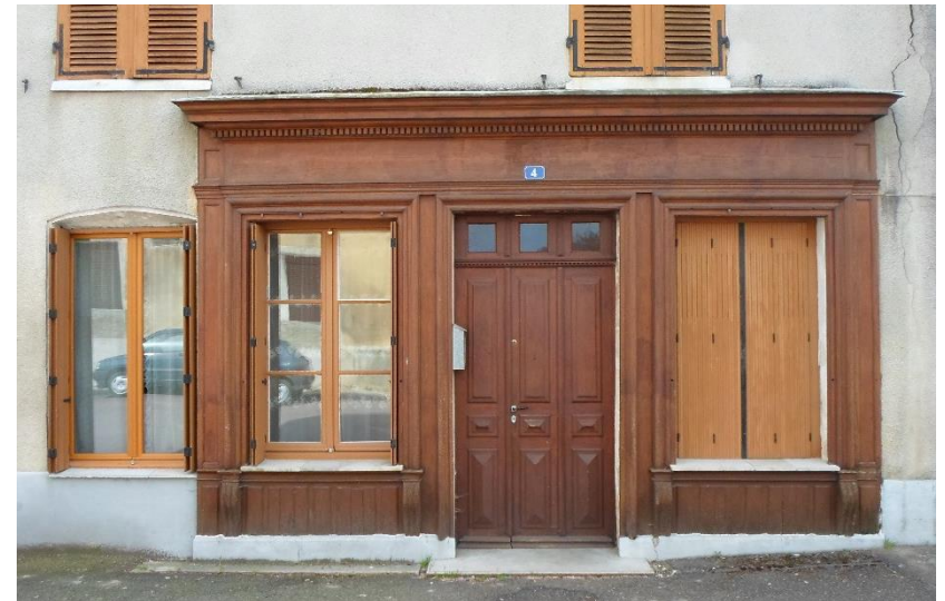
Ancienne devanture commerciale rue Boursault, transformée en logement (une peinture permettrait de redonner une touche de couleur dans la rue)
