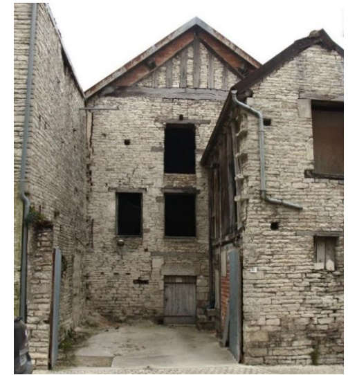
Façade en moellons de pierre calcaire
