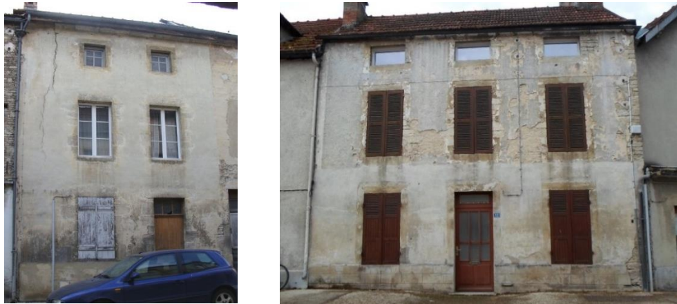
Façades enduites avec encadrements de baies en pierre
